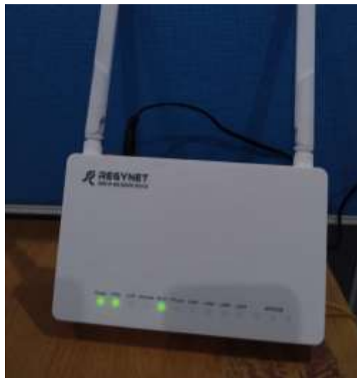
Gambar 5 Pemasangan ONT di rumah pelanggan
