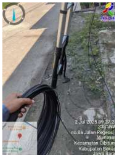
Gambar 3 Penarikan Kabel FO dari ODP ke rumah pelanggan
