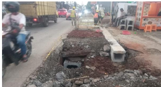
Gambar 3. Pekerjaan saluran air utama dan saluran tangkap
