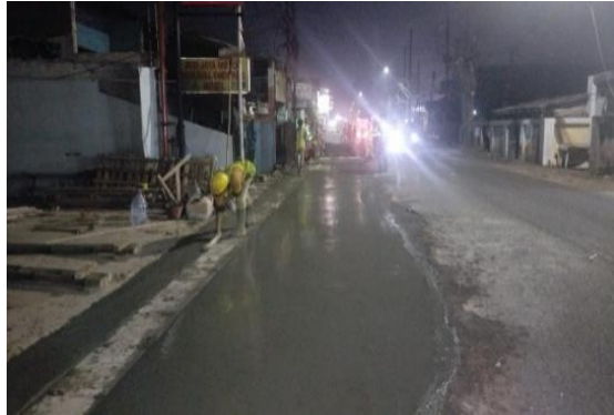
Gambar 2. Pekerjaan pelebaran jalan dengan beton
