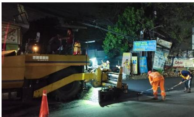
Gambar 1. Pengekerjaan pengaspalan di malam hari Pekerjaan marka jalan
