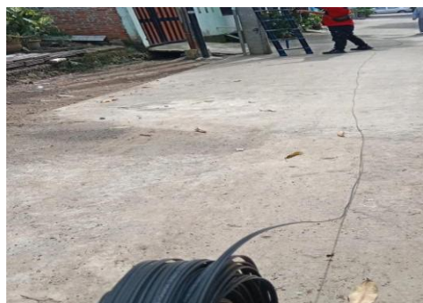
Gambar 1. Penarikan Kabel FO dari ODP ke Rumah Pelanggan
