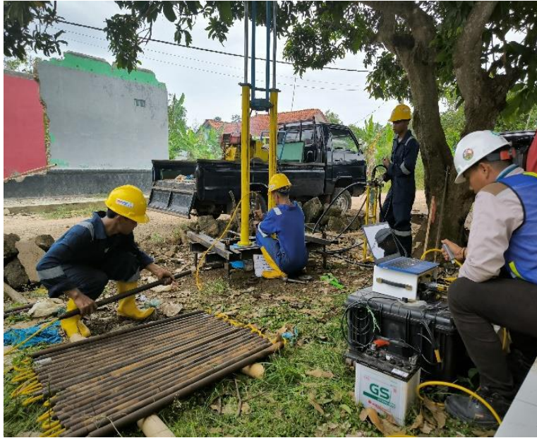
Gambar 10. Proses Pemasangan Alat CPTu
