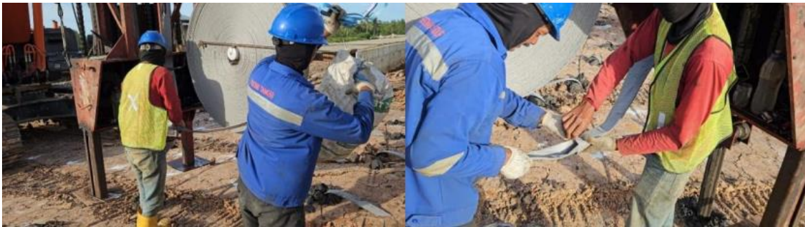
Gambar 1. Pemasangan PVD ke Alat ( PVD Instalation Machine ).
