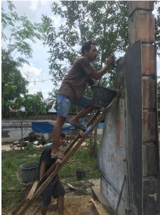
Gambar 4. Perbaikan struktur gapura dan peninggian dinding penahan gapura
