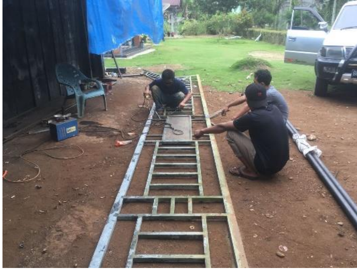
Gambar 2. Proses pembuatan palang penanda Gapura Desa Limau Manis
