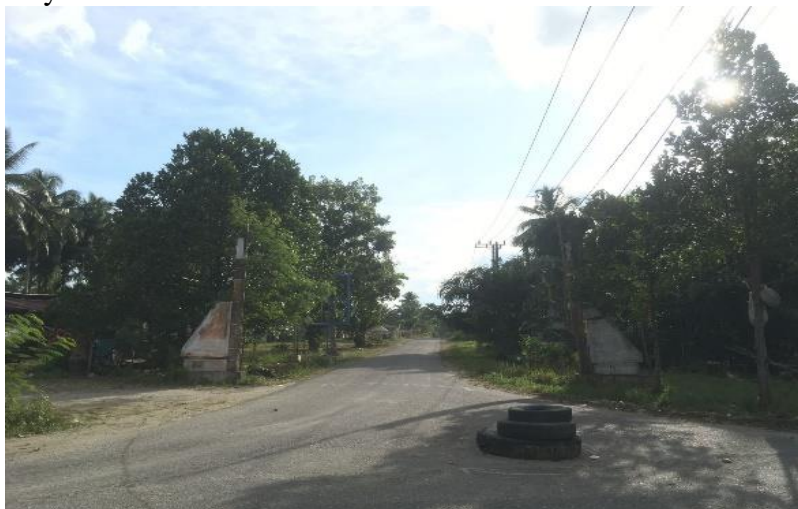
Gambar 1. Kondisi lokasi gapura di Desa Limau Manis
