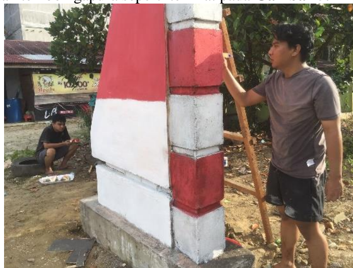
Gambar 5. Pengecatan bertahap pada gapura
