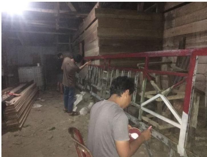
Gambar 3. Proses pengecatan pada palang penanda gapura
