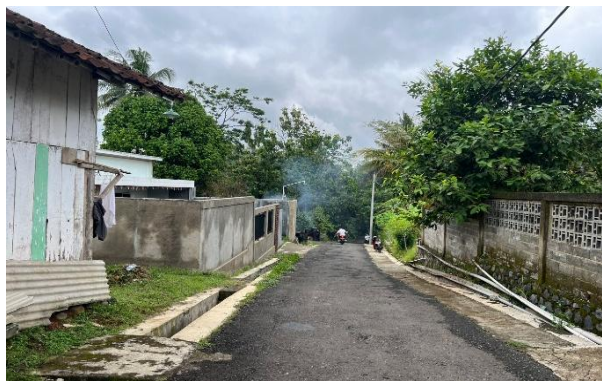
Gambar 1. Kondisi eksisting jalan lingkungan RT 02 RW 04 Kelurahan Wangon sebelum pelaksanaan pendampingan.
