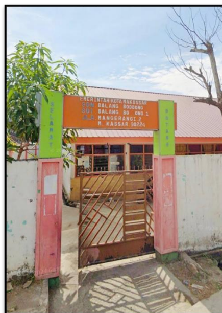
Gambar 1. Tampak depan SDN Balang Boddong
