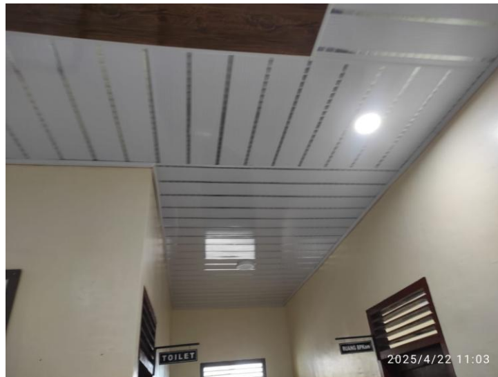
Gambar 9. Finishing Pemasangan Plafon PVC
