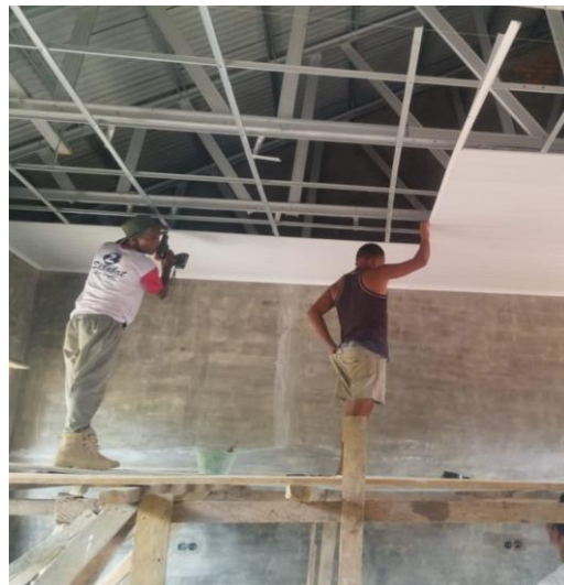
Gambar 8. Proses pengerjaan pemasangan plafon
