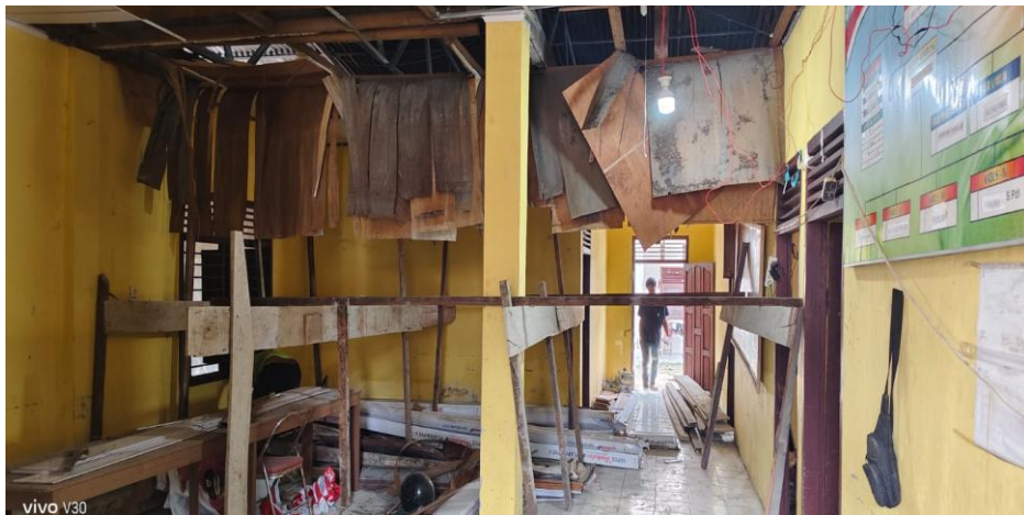
Gambar 7. Pembersihan area kerja dan pembongkaran existing
